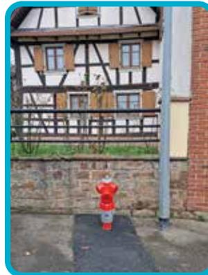
Ces nouveaux poteaux d'incendie normalisés DN 100 mm à 3 sorties remplacent les PI supprimés
