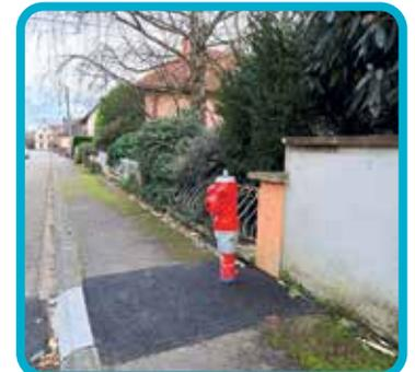
Mises à niveau de divers avaloirs d'eaux pluviales, reprise de pavage et d'enrobés et sécurisation des passages piétons par la suppression d'un espace vert et par la consolidation des potelets, et mise en place de silhouettes réfléchissantes etc...
